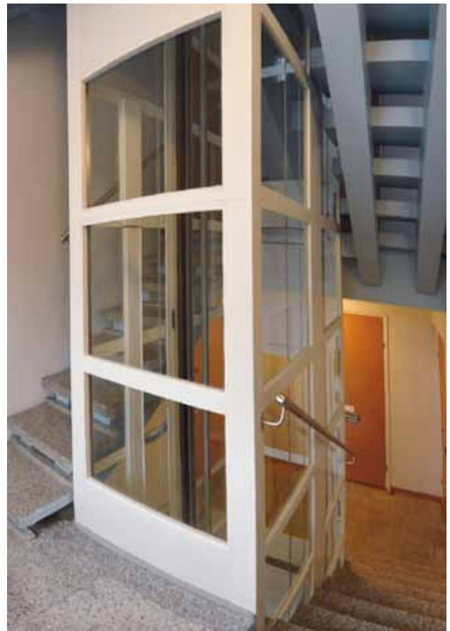
Der KONE Motala™ 6000 LS Aufzugsschacht ist selbsttragend wodurch keine Belastung der Gebäudemauern entsteht.
